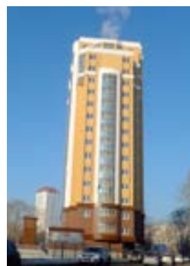
ГАК на ул. Гражданская, г. Екатеринбург
