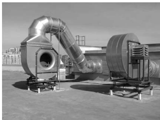
Вентиляторы ВРАН®, установленные на виброизоляторы типа «ДО» до и после штормового ветра в С-Петербурге.
