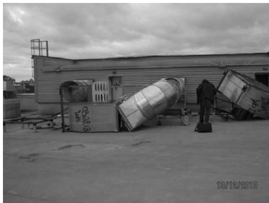
Вентиляторы ВРАН®, установленные на виброизоляторы типа «ДО» до и после штормового ветра в С-Петербурге.
